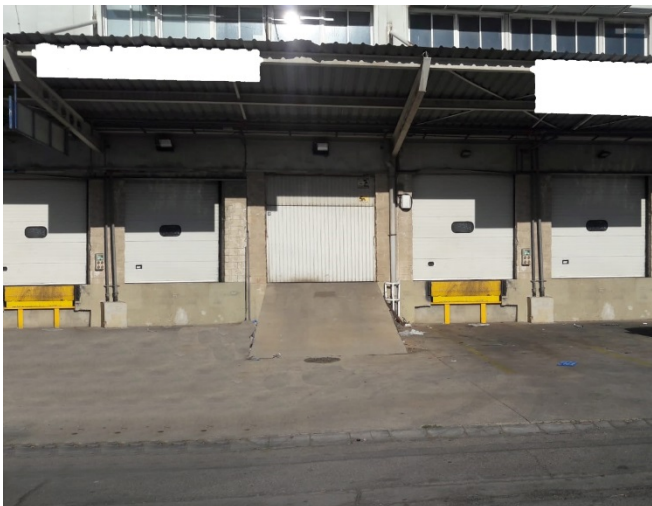
Zona de muelle
